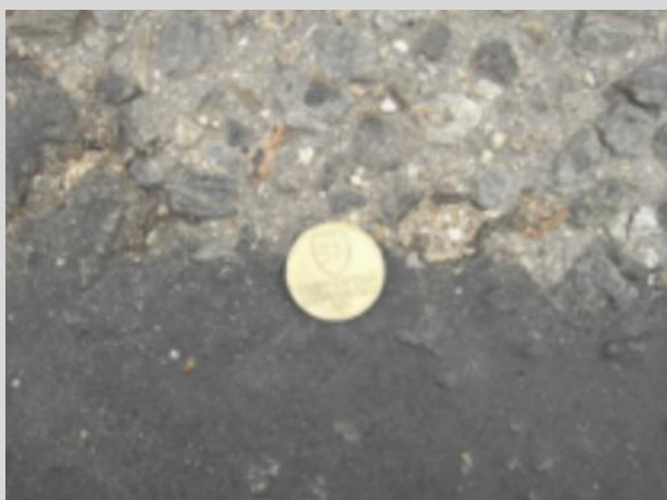
Rozdíl mezi vozovkou ošetřenou a neošetřenou regeneračním postřikem CRF®
