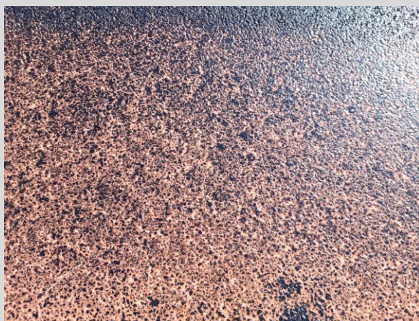
Vozovka těsně po aplikaci postřiku Reclamite®
