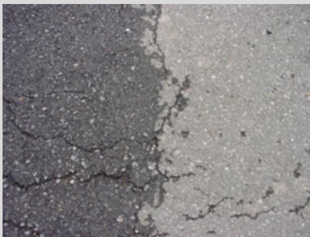
Rozdíl mezi ošetřenou a neošetřenou vozovkou 4 roky po aplikaci Reclamite®
