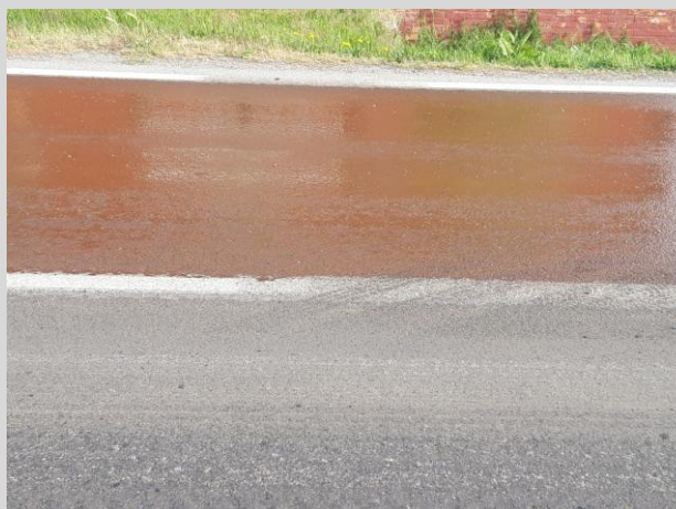
Vozovka těsně po aplikaci postřiku CRF®
